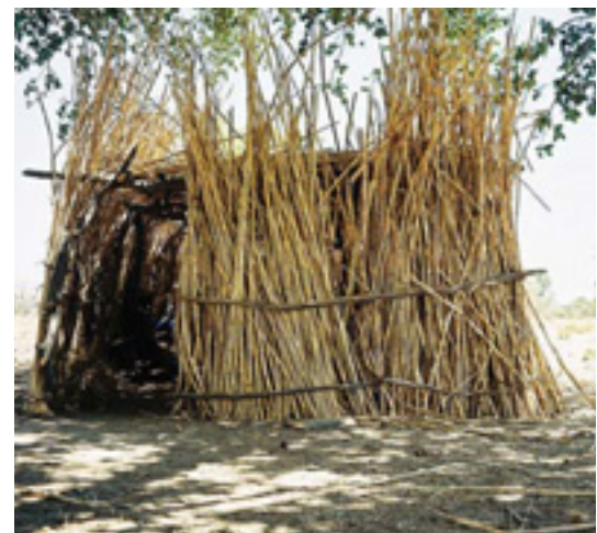
Un hangar en matériaux locaux, abritant un centre d'alphabétisation fonctionnant cinq jours par semaine, dans la région de Makalondi, zone frontalière du Niger et du Burkina Faso.
